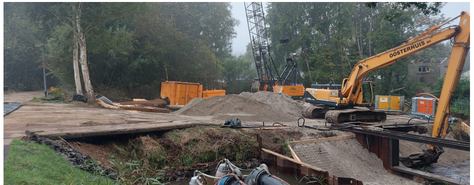
Het 'bed' voor de Eelderwolderpolderstuw wordt aangelegd en voorzien van betongaas.
